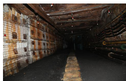
图 1 厚表土薄基岩柔模混凝土沿空留巷现场施工效果图
