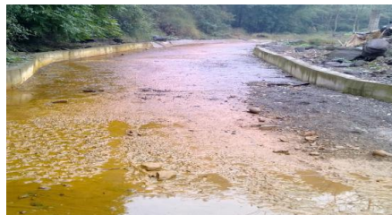
图 3 河床导洪排水防护渠
