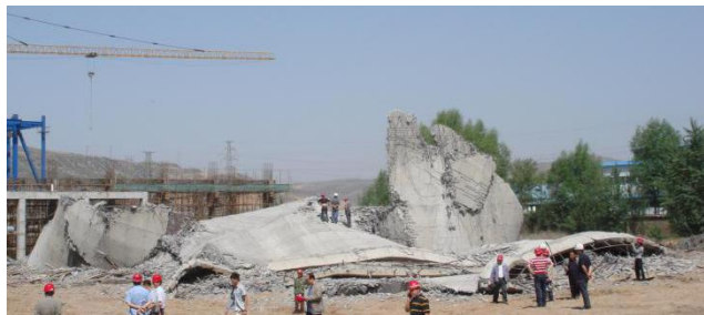
图1 冷却塔高位弱化、低位爆破倒塌效果-神木电厂
